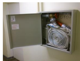
Pilt 2 Tuletõrje voolikusüsteemi kapp
